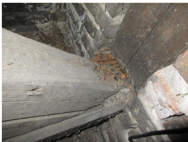
Foto 46 Zóna C/4.úsek/L: Trám /päťka-0,7m/ – H, F, Č (3-4) Stĺp – H, F, Č (3) Vzpera kolmá /päťka-0,3m/ – H, Č (3)
