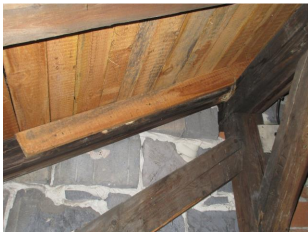
Foto 40 a 41 Zóna C: Dopĺňujúce pohľady na hnilobné poškodenia krokvy a väznice uvedené na foto 39 (PS: Na foto 41 vid' detail na vyschnuté staré plodnice huby Antrodia vaillantii )
