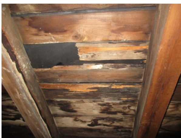
Foto 24 Zóna B/1.úsek/L: Latovanie /1c-2/ - H, F (3) - zasolenie
