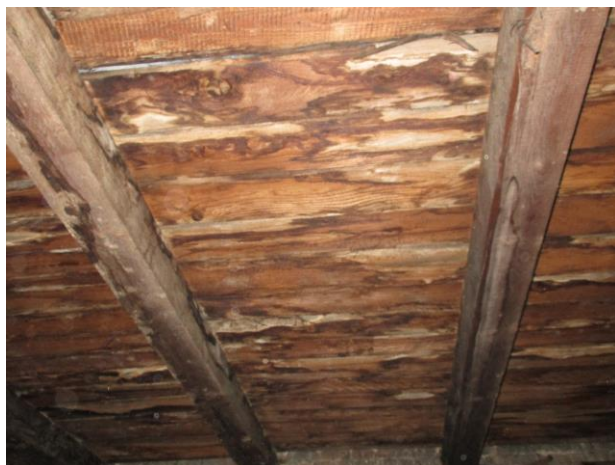
Foto 15 a 16 Zóna A/3.úsek/P: Latovanie /3b-3c/ - zasolené, avšak v týchto miestach bez výraznejšej hniloby.
