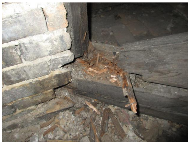
Foto 11 Zóna A/2.úsek/L: Trám úžľabový/päťka-1m/ – H, F, Č (3-4) Stĺp v úžľabí – H, F, Č (3-4) Pomúrnicia spodná /1 2c/ – /1m pri úžľabí/ – H, F, Č (3) Vzpera úžľabová /päťka/ – H (2)
