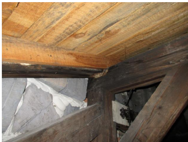
Foto 39 Zóna C/1.úsek/P: Krokva /pri väznici/ – H (3-4) S: Väznica /pri krokve/ - H (3 až 3-4)
