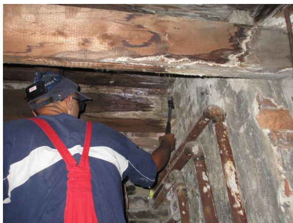
Foto 25 a 26 Zóna B/1.úsek/L: Väznica vrcholová i krokvy – zasolenie (biela soľ na povrchu dreva)
