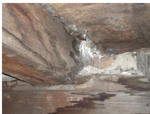
Foto 18 Zóna A/5.úsek/L: Krokva /päťka-0,2m/ – H (2-3)
