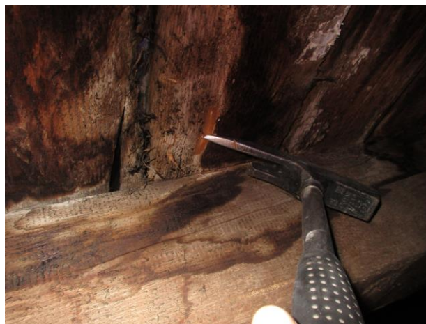
Foto 15 a 16 Zóna A/3.úsek/P: Latovanie /3b-3c/ - zasolené, avšak v týchto miestach bez výraznejšej hniloby.
