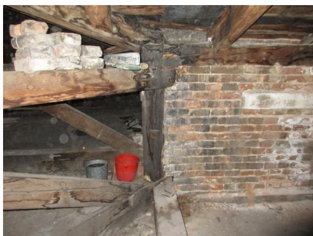
Foto 19 Zóna A/5.úsek/L: Trám úžľabový /päťka-1m/ – H (3-4)
