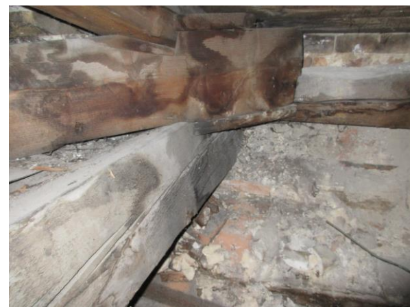
Foto 32 Zóna B/7.úsek/P: Väzný trám /päťka-1,5m/- H (3) Pomúrnica vrchná /6c-7/ - H (3 až 3-4)
