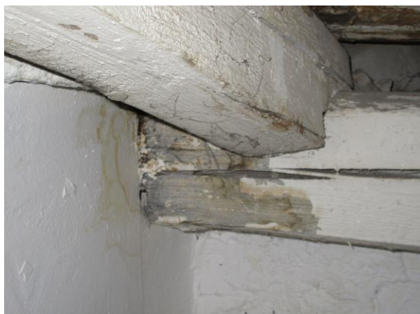
Foto 33 až 36 Zóna B/Pri schodisku I. – kontakt s 1. úsekom: Prvky krovu ošetrené zrejme protipožiarným náterom bielej farby.
