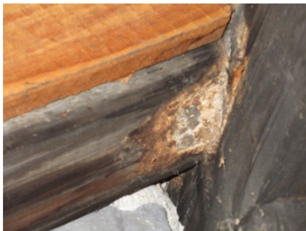
Foto 40 a 41 Zóna C: Dopĺňujúce pohľady na hnilobné poškodenia krokvy a väznice uvedené na foto 39 (PS: Na foto 41 vid' detail na vyschnuté staré plodnice huby Antrodia vaillantii )
