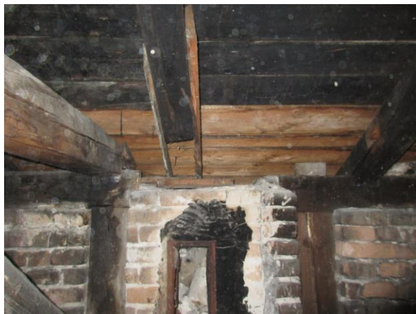
Foto 44 Zóna C/4.úsek/S: Krokva kolmá – Hnilá časť vylomená a príložkovaná
