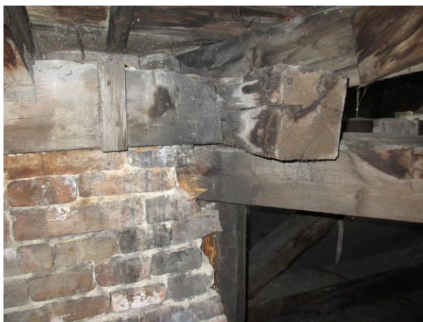
Foto 10 Zóna A/2.úsek/L: Pomúrnicia vrchná /1 2c/ /0,5m pri úžľabí/ – H, F, Č (2-3) Stĺp v úžľabí – H, F, Č (3-4) Krokva úžľabová /päťka-1m/ – H, F, Č (3 až 3-4) Klieštiny úžľabové /päťky-0,5m/ – H, F, Č (2 až 3)
