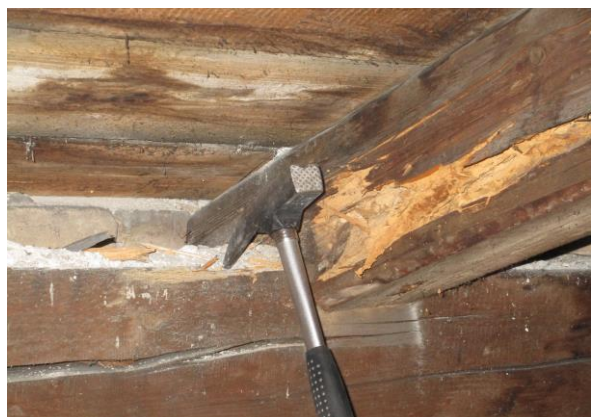
Foto 8 Zóna A/2.úsek/L: Krokva (a) /pätka-1m/ – F (3) Pomúrnica vrchná /2-2a/ – F (2)
