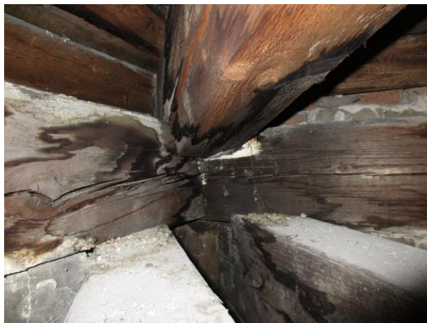
Foto 21 Zóna A/5.úsek/L: Krokva nárožná /päťka-0,3m/ – H (2)
