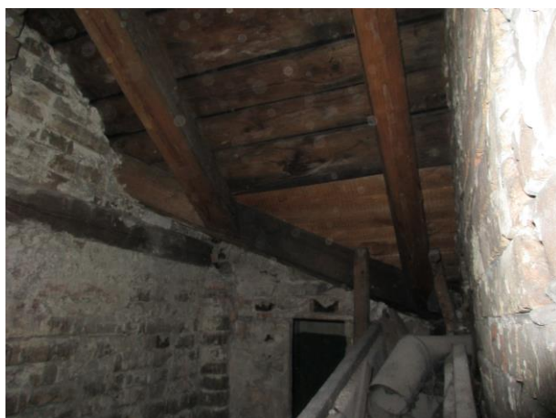
Foto 37 Zóna B/Pri schodisku II. – kontakt so 7. úsekom: Prvky krovu bez známk zjavnejších biologických poškodení.
