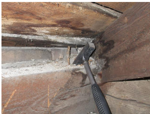
Foto 9 Zóna A/2.úsek/L: Pomúrnicia vrchná /2b-2c/ – H, F (2-3 až 3) Krokva nárožná /päťka/ – H (1-2)
