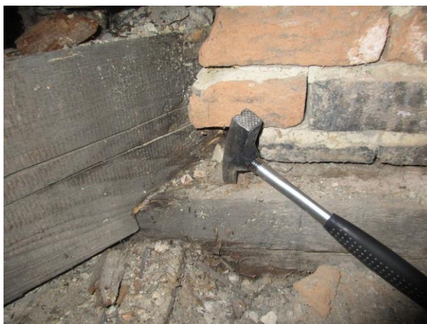
Foto 12 Zóna A/2.úsek/L: Pomúrnicia spodná /2c-3/ – H, Č (3) Trám úžľabový/päťka-1m/ – H, F, Č (3-4)
