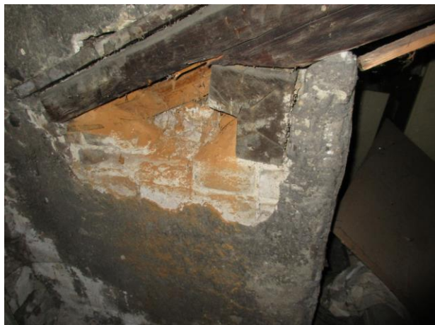
Foto 52 Zóna D/1.úsek/P: Krokva (c) /pätk-1,5m/ – H, F, Č (3-4) Pomúrnic vrchná – H, F (3-4)
