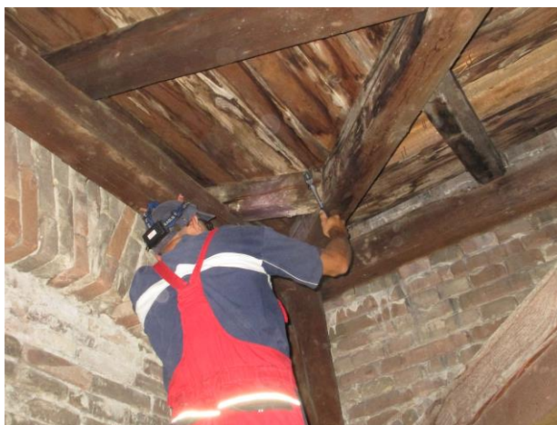
Foto 22 Zóna A/6.úsek/P: Krokva kolmá (a) - zasolenie
