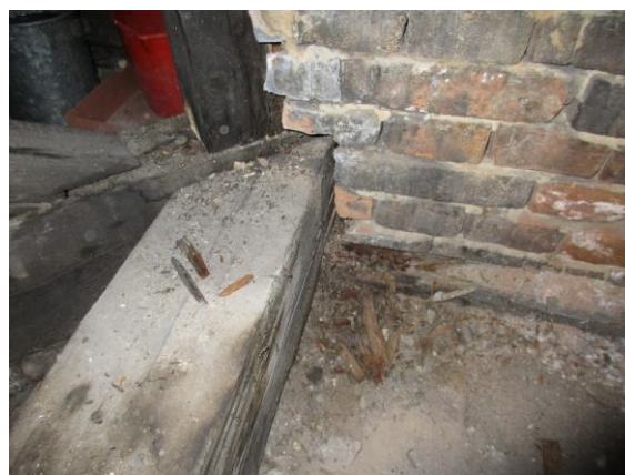
Foto 20 Zóna A/5.úsek/L: Trám spojový /päťka-1m/ – H (3)
